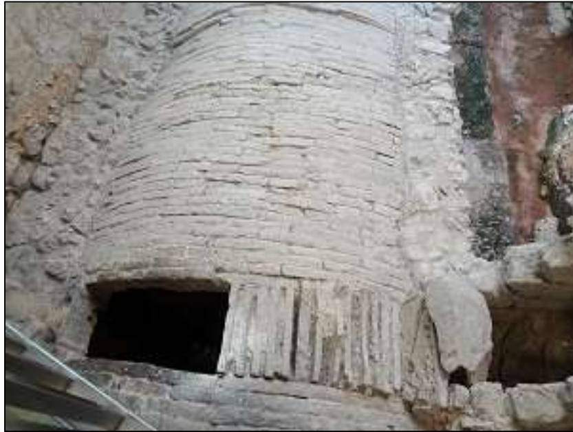
Εικόνα 3. Τμήμα της κοίτης του Ηριδανού ποταμού στον Σταθμό Μοναστηράκι .
